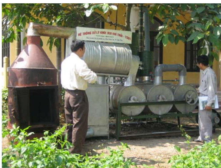
Hình 7.3 Lò đốt tại bệnh viện đa khoa Hoà Bình
